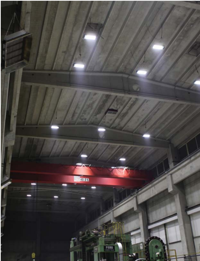
Oświetlenie zwiększono z 150 lux na 350 lux.
