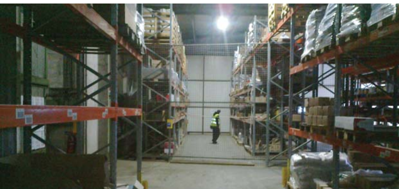
100% oświetlenie przy obecności pracowników, przejeżdżających wózków widłowych lub innych pracujących maszyn (moc 120 W).
