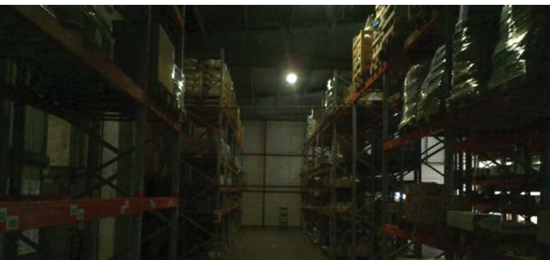
30% oświetlenie w pustym pomieszczeniu magazynowym (moc 35 W).
