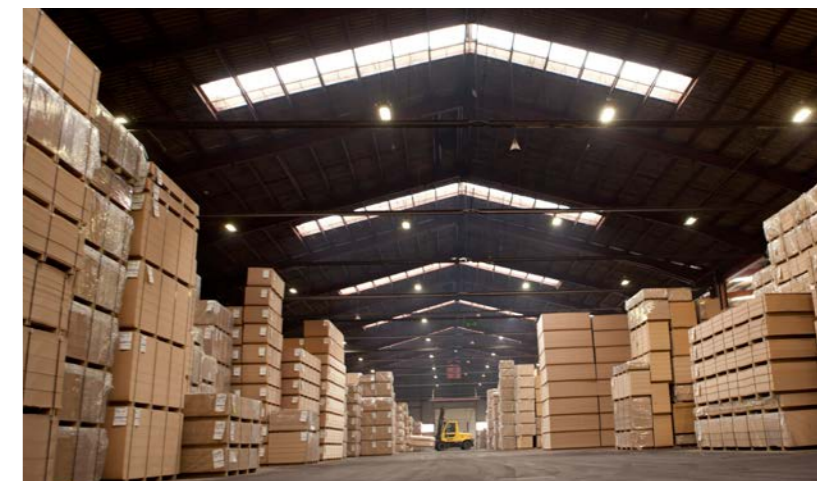
Iluminação após o investimento (130-180 lux)
