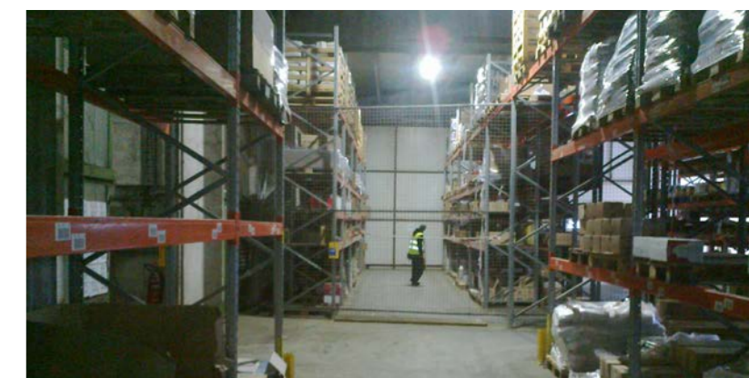
Iluminação a 100% na presença de pessoal, empilhadores ou outra maquinaria (120 W de potência)
